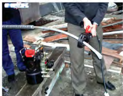
Резка провода АС-300/39 универсальным неавтономным резак SP-32
