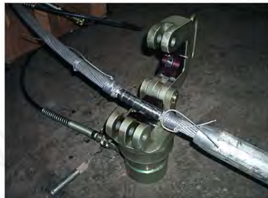
Пресс EP-520C. Опрессовка анкерного зажима соединителя SAC-300-1.
