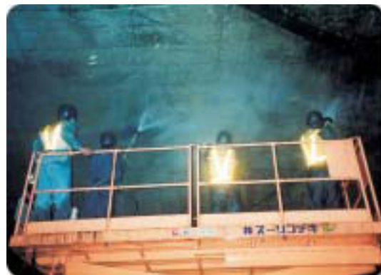
Чистка внутренних поверхностей туннеля.
