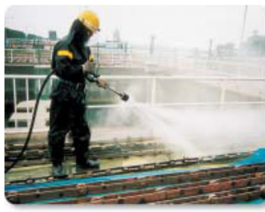
Чистка цепей водяного экрана
