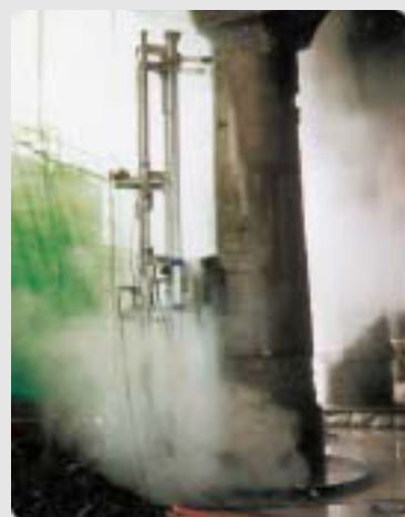
Дробление бетонной опоры
