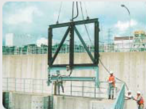
Чистка затвора водоприемника
