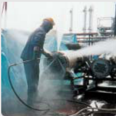
Чистка трубы теплообменника изнутри
