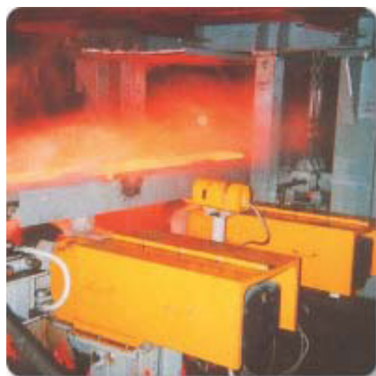
Удаление окалины во время работы прокатного стана
