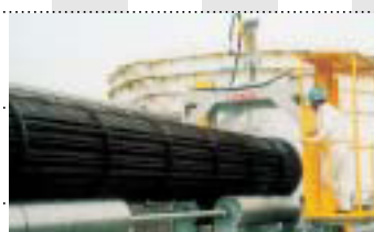
Внешняя очистка труб теплообменников
