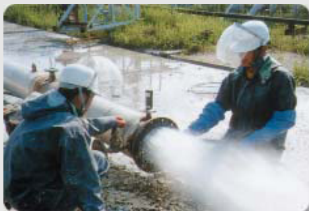
Чистка больших труб
