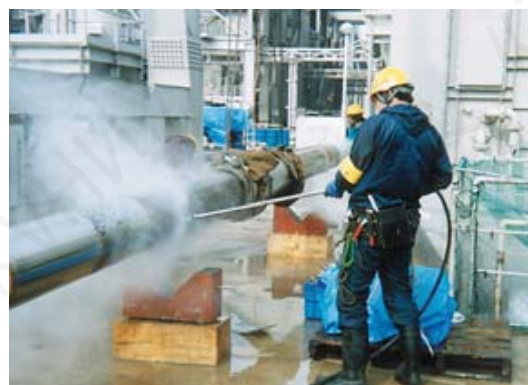
Очистка поверхности большой трубы
