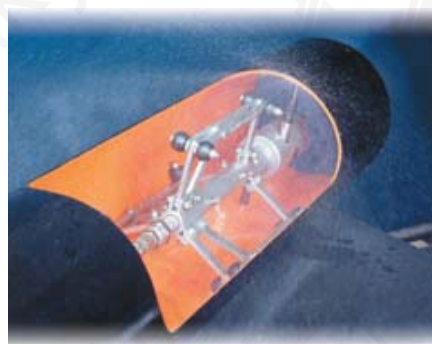
Чистка большой трубы при помощи 2D форсунки.
