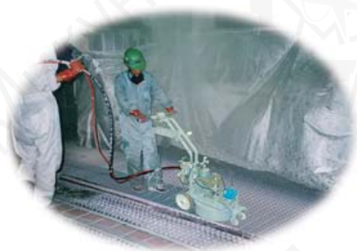
Зачистка слоя краски с решетчатого настила покрасочного цеха
