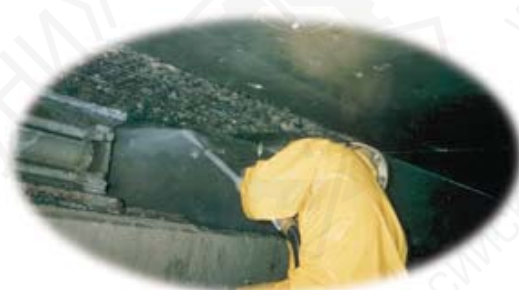
Удаление покрытия с опоры моста
