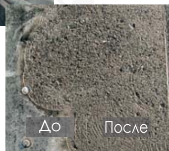
Поверхность бетона после зачистки
