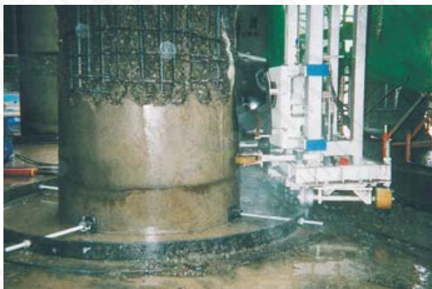
Модуль для зачистки/разрушения железобетонных конструкций на рельсовых направляющих
