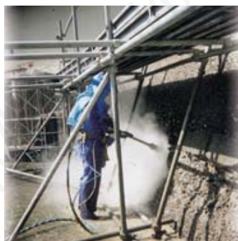
Дробление бетона гидроканала
