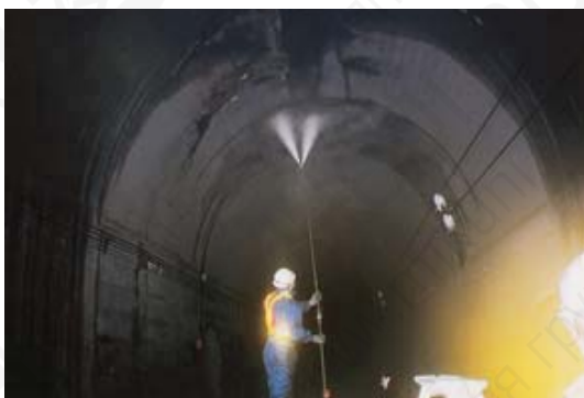
Чистка поверхностей тунеля
