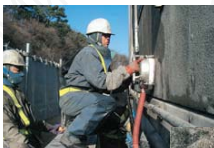
Текстурирование бетонной поверхности
