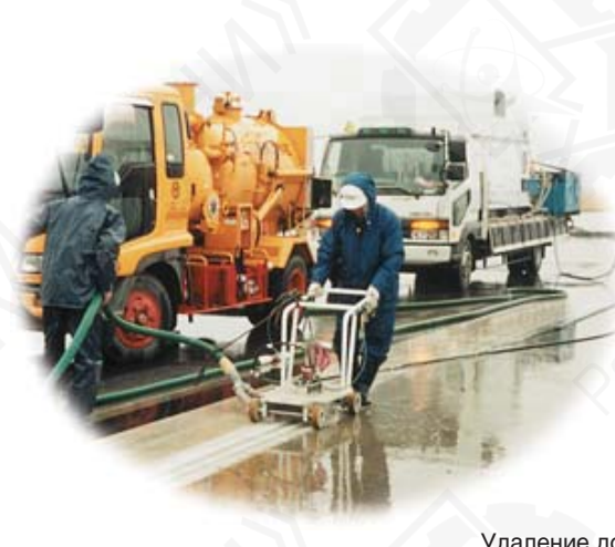
Удаление дорожных, разметочных линий
