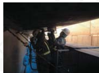
Обработка поверхности в целях предотвращения отслаивания бетона
