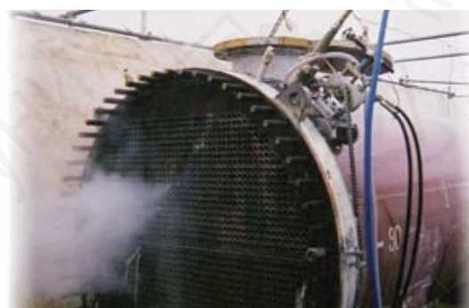
Разборка теплообменника
