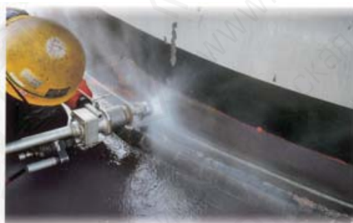
Удаление покрасочного слоя с нефтяной емкости
