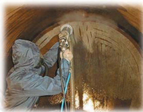
Удаление покрытия внутренних стен резервуаров
