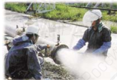
Чистка больших труб
