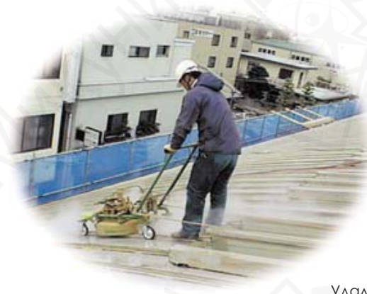
Удаление покрасочного слоя с крыши
