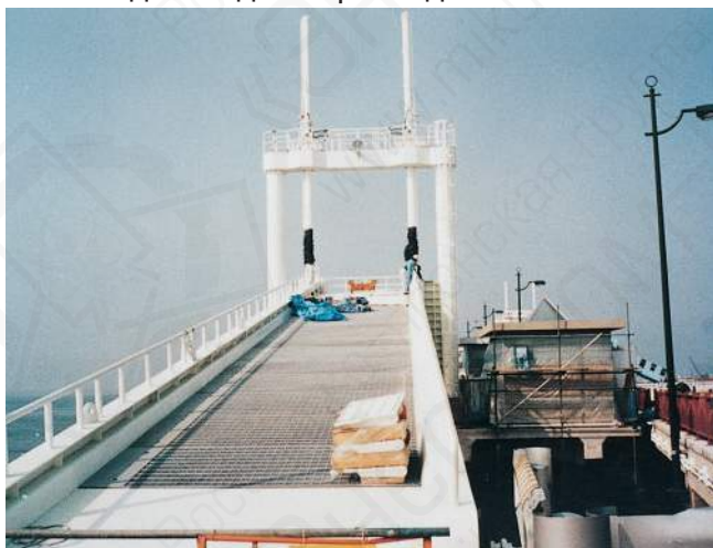
Длина штока гидравлического цилиндра 8720мм, диаметр 250мм.
