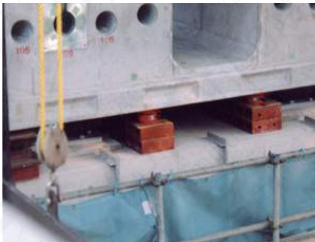
Низкий домкрат JFN200S3 с фиксирующей гайкой
